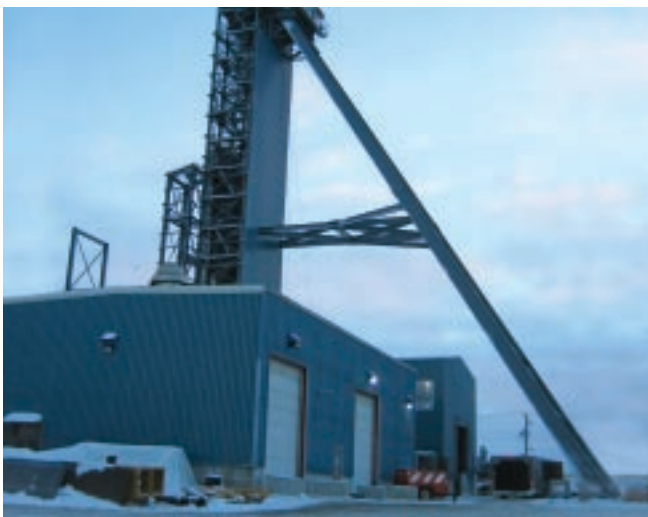
Construction du chevalement de Lapa, maintenant terminée.
